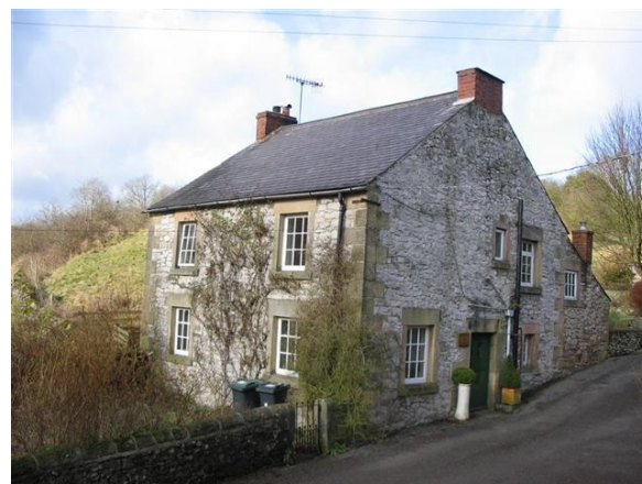
P.5.12. Dale House, Bankside
